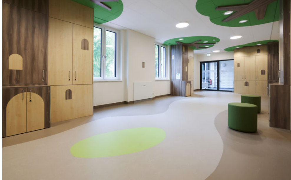
Bei den Intarsien und den geschwungenen Nähten der Wegführungen konnte dank dichtgestoßener Nähte auf das Verfügen verzichtet werden (auf dem Foto: „Marmoleum Decibel“, Forbo).
